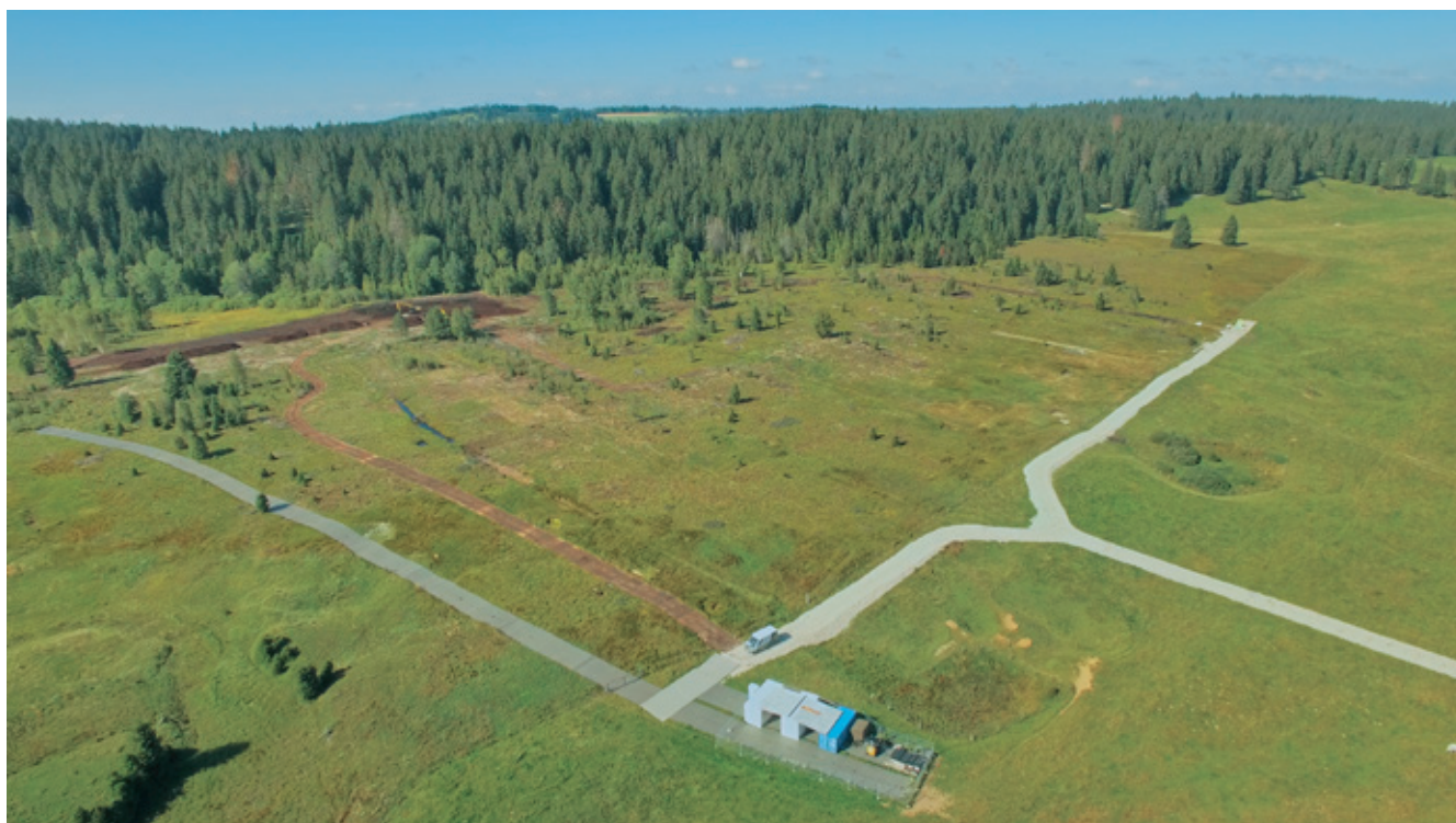
Vue aérienne de la zone de projet pendant les travaux en 2021.
