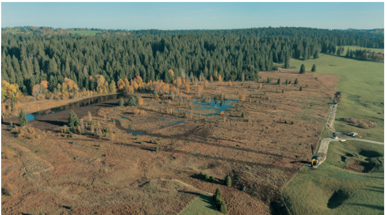
Vue aérienne de la zone de projet fin 2022 montrant la fin des travaux à l'intérieur de la tourbière.
