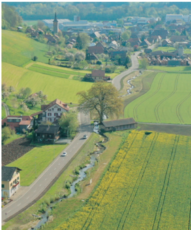
Blick Richtung Oberburg auf einen revitalisierten Abschnitt mit Schützenhaus und mächtiger Eiche beim Steingrübli (Bildmitte). (Foto: Schwellenkorporation Oberburg)
