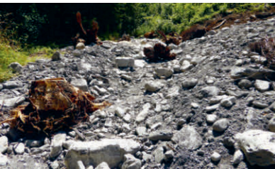
Während der Renaturierung – auf den Pressschlamm wird eine Kiesschicht angelegt
