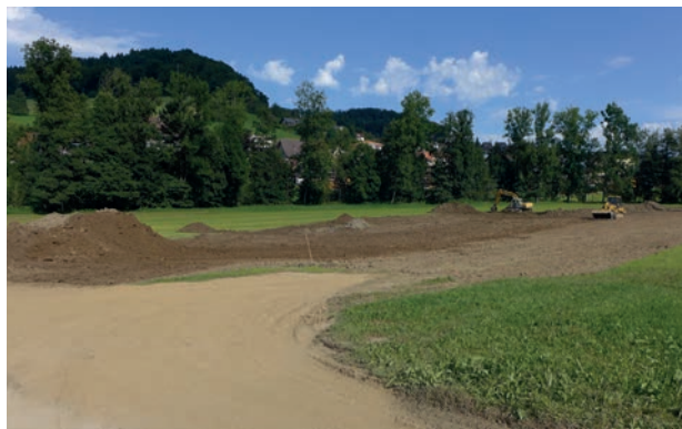
Der Hauptteil der 1,2 Hektaren wurde abhumusiert, um Gewässer und magere Wiesen zu schaffen.
