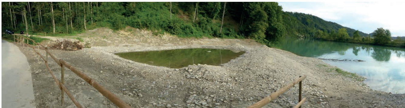
Fertiggestellter Amphibienweiher in Radelfingen Salzbach.
