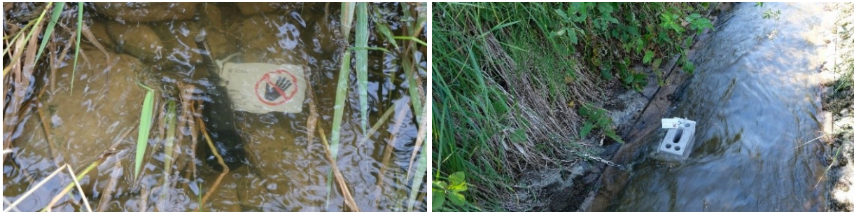
Abbildung 14: Installierte Temperaturlogger des Typs Hobo U22-001 zur exakten Messung und Aufzeichnung der Wassertemperaturen. Je nach Sohlen- und Uferstruktur kommen unterschiedliche Befestigungsvorrichtungen zu Einsatz (Fotos eQcharta, 6.7.2022)
